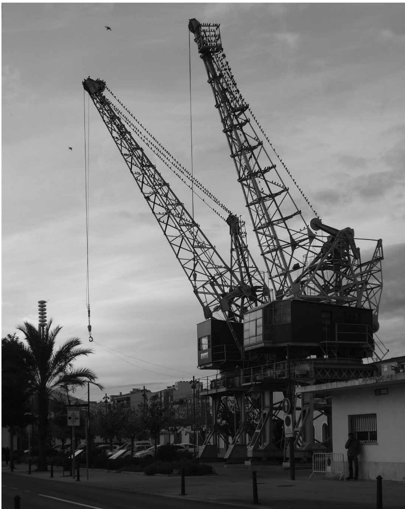
1. Tarragona (Spagna). Porto, gru elettriche restaurate (foto Franco Mancuso, 2019).
