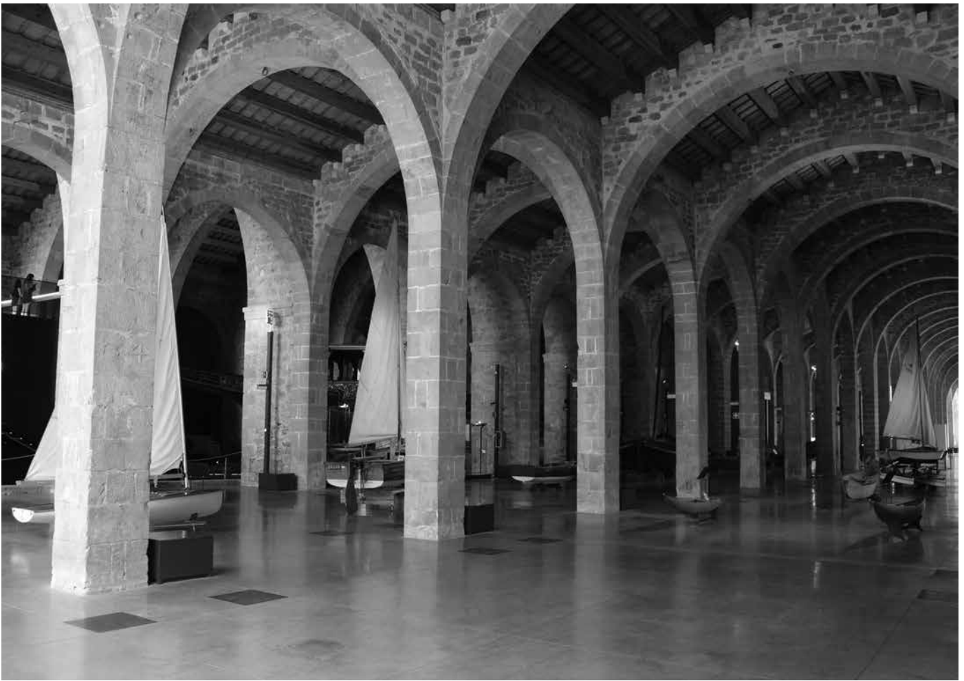
5. Barcellona (Spagna). Atarazanas, oggi sede del Museu Maritim de Barcelona. Si nota la struttura in blocchi quadrati in roccia locale di Montjuich (foto Domenico DeBenedictis, 2017).
