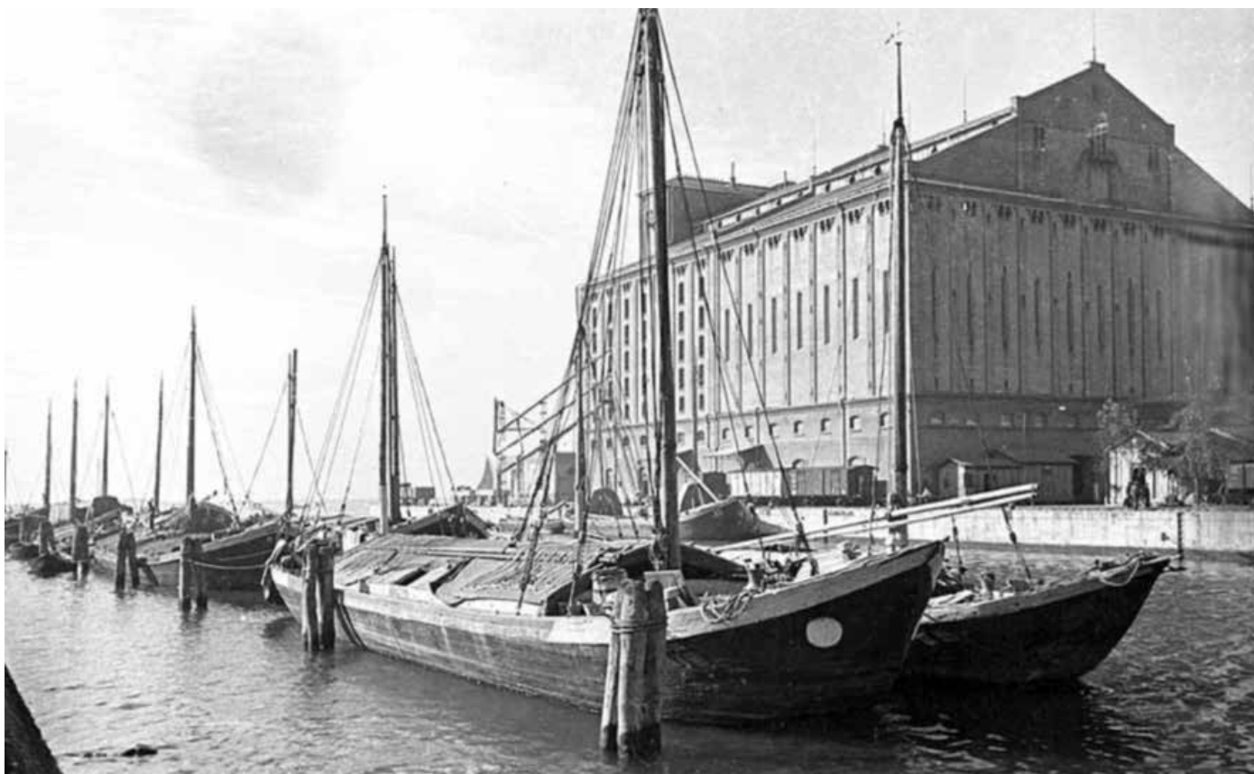
3. Venezia. Silos alla Stazione Marittima, con barconi per il trasporto fluviale (Archivio Giacomelli; primi decenni del Novecento).
