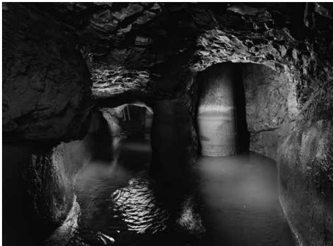
6. Fermignano (Pesaro e Urbino). Tunnel 42, canale di scarico della centrale idroelettrica, in parte scavato nella roccia e in parte in volta di mattoni (foto Silvano Bacciardi, 2019).
