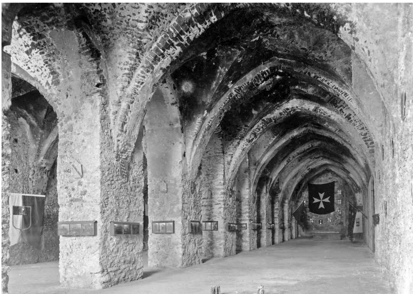
6. Amalfi. Arsenali, le due navate superstiti prima dei lavori di recupero in spazio museale (foto Trapezaki, 2017).
