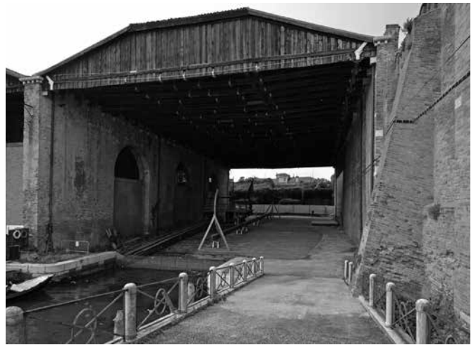
9. Venezia. Arsenale, Squeri cinquecenteschi, detti dei mestieri , vista verso la darsena. A sinistra uno squero di terra, a destra uno squero d'acqua. Si possono osservare le caratteristiche mezze padigionature delle coperture (foto Claudio Menichelli, 2004). 10. Venezia. Arsenale, Cantieri alti delle Galeazze, vista del fronte acqueo (foto Claudio Menichelli, 2014).
