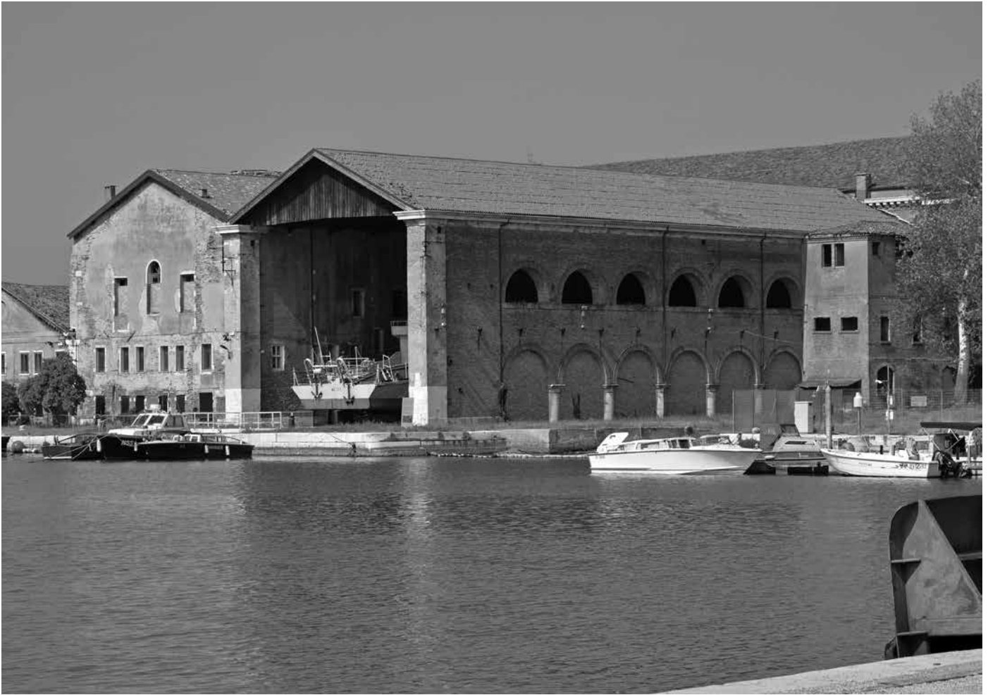
11. Venezia. Arsenale, vista dalla darsena Novissima di due cantieri di Novissimetta rialzati nel Settecento. Si tratta degli unici esempi superstiti di tutta l'operazione di sopraelevazione (foto Claudio Menichelli, 2012).
