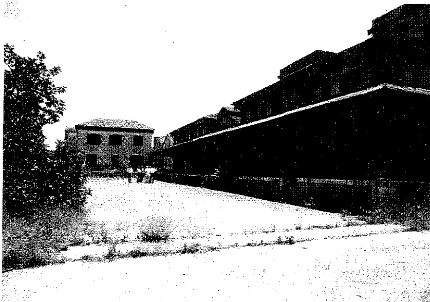
Ex-distilleria. Veduta del corpo principale. In primo piano la pensilina sorretta da colonnine in ghisa
