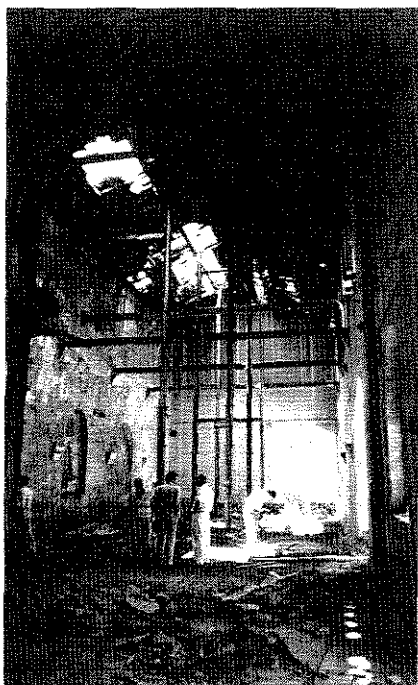
Ex-distilleria. Interno di uno dei capannoni
