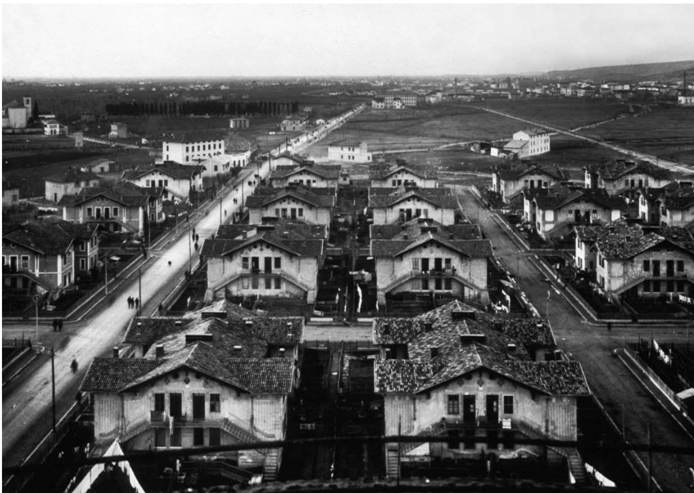
Monfalcone (Gorizia). Edifici del tipo a blocco ad 8 alloggi fotografati dalla torre dell'acquedotto, una delle opere infrastrutturali più importanti realizzate (Archivio Consorzio Culturale del Monfalconese).
